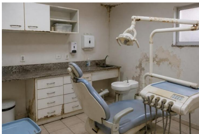
FIG.16: Consultório em más condições
